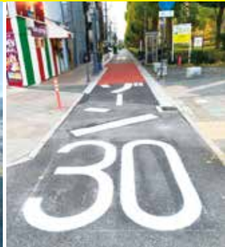
常盤小通学路の改修
