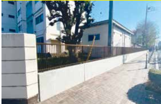
常盤小の壁が完成
